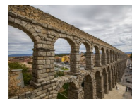
D. 高架引水渠
