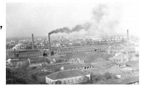
汉阳铁厂是中国第一个近代化的钢铁厂
