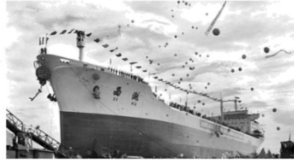
1960年,中国自行设计、建造的第一艘万吨级远洋货轮——“东风号”下水
