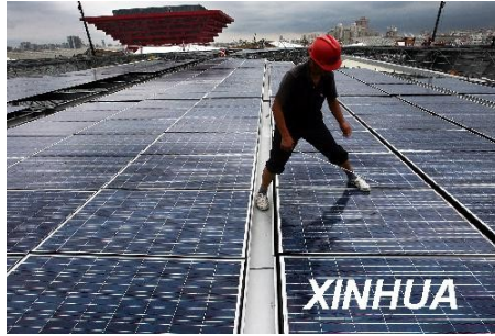
工人正在检查上海世博会使用的太阳能板
