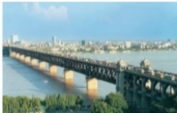
武汉长江大桥
