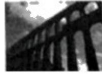
D. 高架引水渠
