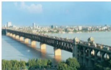
武汉长江大桥
