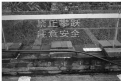
古城墙玻璃围栏警示牌
